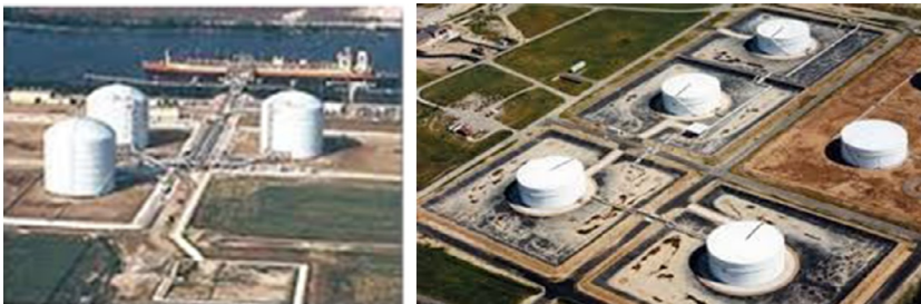
LNG storage tanks showing earth berm
