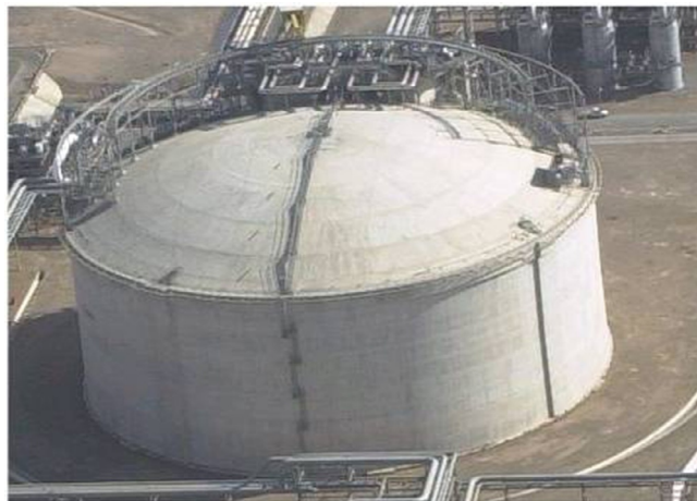
LNG tank showing piping
